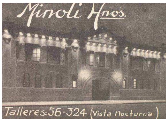
Imagen 6- Fábrica Metalúrgica Minoli Hnos. Frente calle 56 N° 324. La Plata. Situación original, 1931. Propaganda en Revista La Construcción de La Plata.
