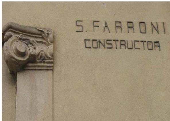
Imagen 7- Fábrica Metalúrgica Minoli Hnos. Frente calle 56 Nº 324. La Plata. Constructor Santos Ferroni. Estado actual
